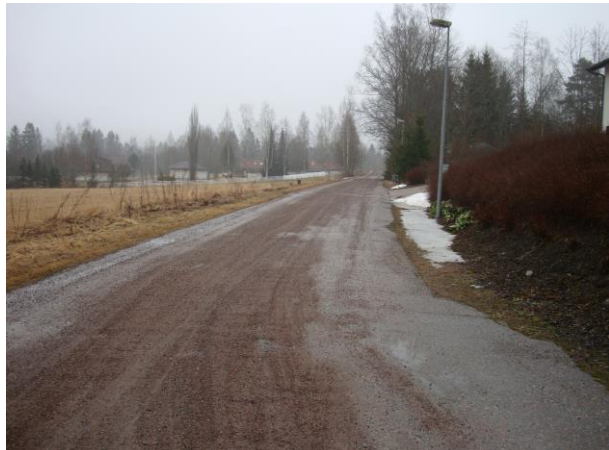
Kuva. Eteläinen tie itäsuuntaan.
