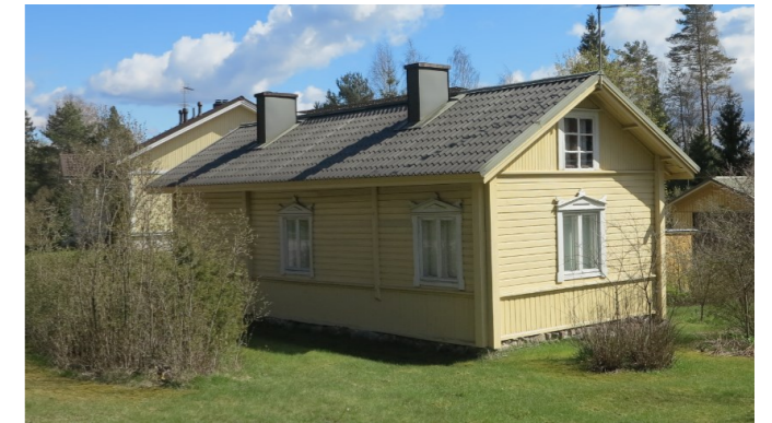
Nyhkäläntie 18 1800-luvun asuinrakennus
