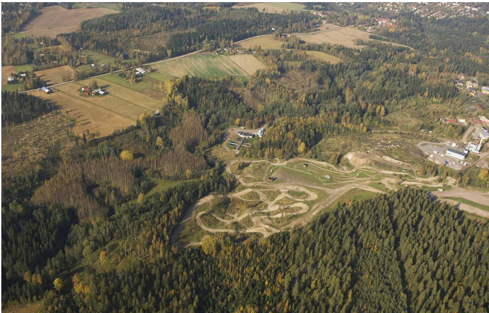
Karjaanjokilaakso idästä. Etuoikealla Harmaakivenmäen metsää, keskellä jätevoimala, maankaatopaikka, jätevedenpuhdistamo ja moottorirata. Jokikanjonin toisella puolella Alimmaisien peltoja, ylävasemmalla Lemmoinvuori,
