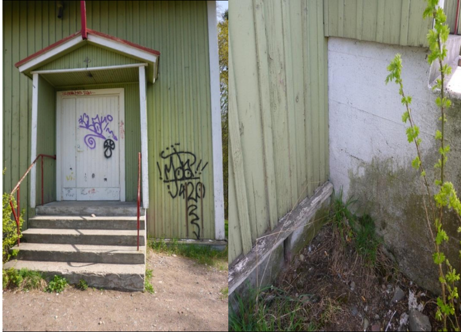
Kuvat 9 ja 10. Rakennuksen julkisivun laudoituksia. Oikeanpuoleisessa kuvassa näkyy alareunan listan lahovaurioita.
