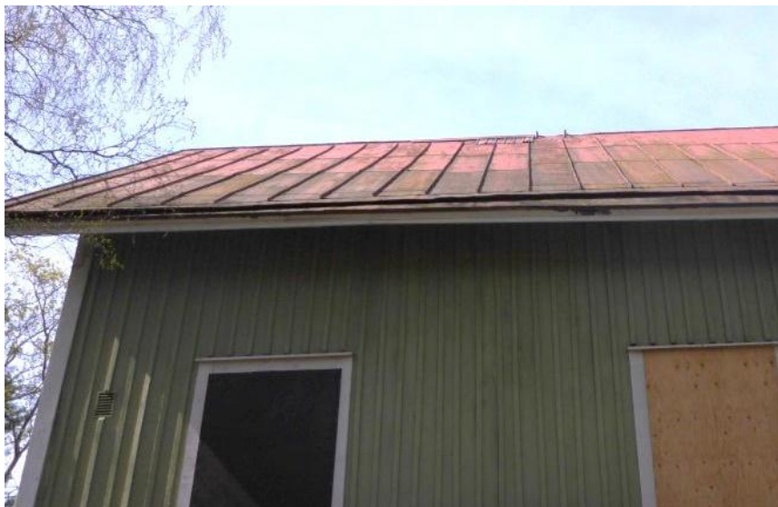
Kuva 12. Yleiskuva rakennuksen katosta
