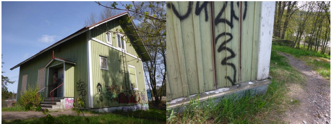
Kuvat 3 ja 4. Rakennuksen sokkelin vierellä on kasvillisuutta ja maanpinnan kallistukset ovat paikoin tasaisia.
