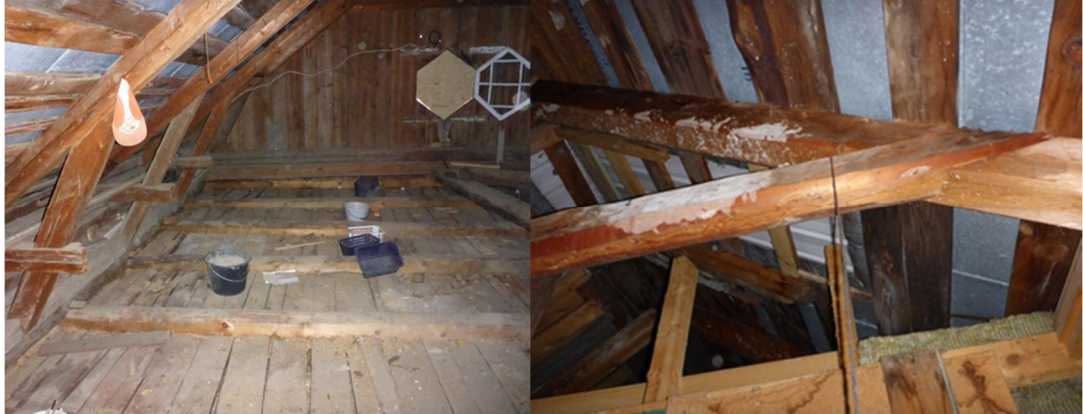
Kuvat 13 ja 14. Kuvia ullakotilasta. Vesikatossa ei ole aluskatemateriaalia. Paikoin on havaittavissa vanhoja vuotojälkiä, jotka eivät olleet tarkastusajankohtana kosteita.
