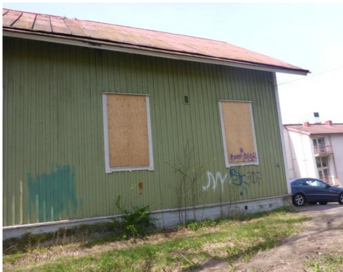
Kuva 8. Rakennuksen ikkunat on peitetty.
