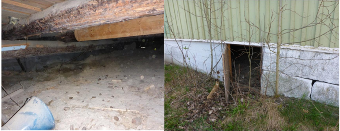
Kuvat 5 ja 6. Ryömintätilaa sisäpuolelta sekä ryömintätilan kulkuluukku.
