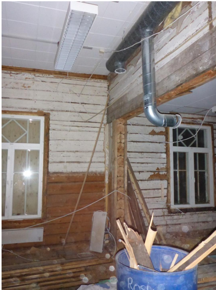
Kuva 11. Hirsirakenne on nähtävissä sisäpuolelta.
