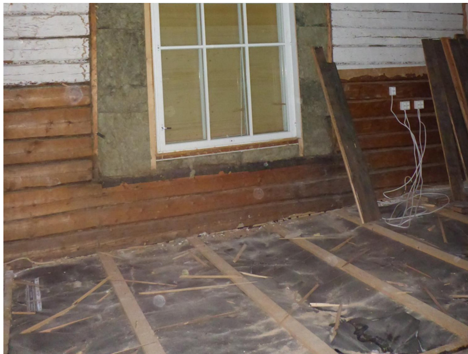
Kuva 7. Alapohjarakenne oli avattu rakennuksen päädystä. Lisäksi kuvassa näkyy pienennetty ikkuna-aukko, jossa ikkunan ympäristö on eristetty mineraalivillalla.
