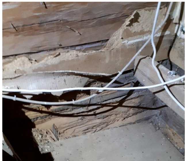
Vuoden 2017 mikrobi tutkimusten ottopaikat toivat esiin tupajumien vaurioittamia hirsii.
