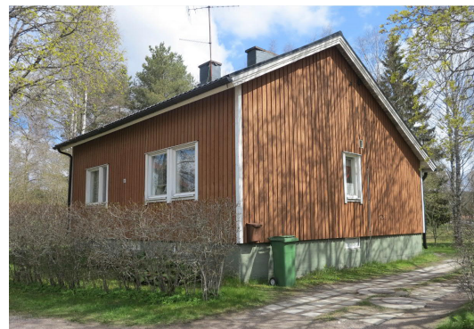
Puutalo Oy:n Högforssin talotyyppi. Korvenkatu 19
