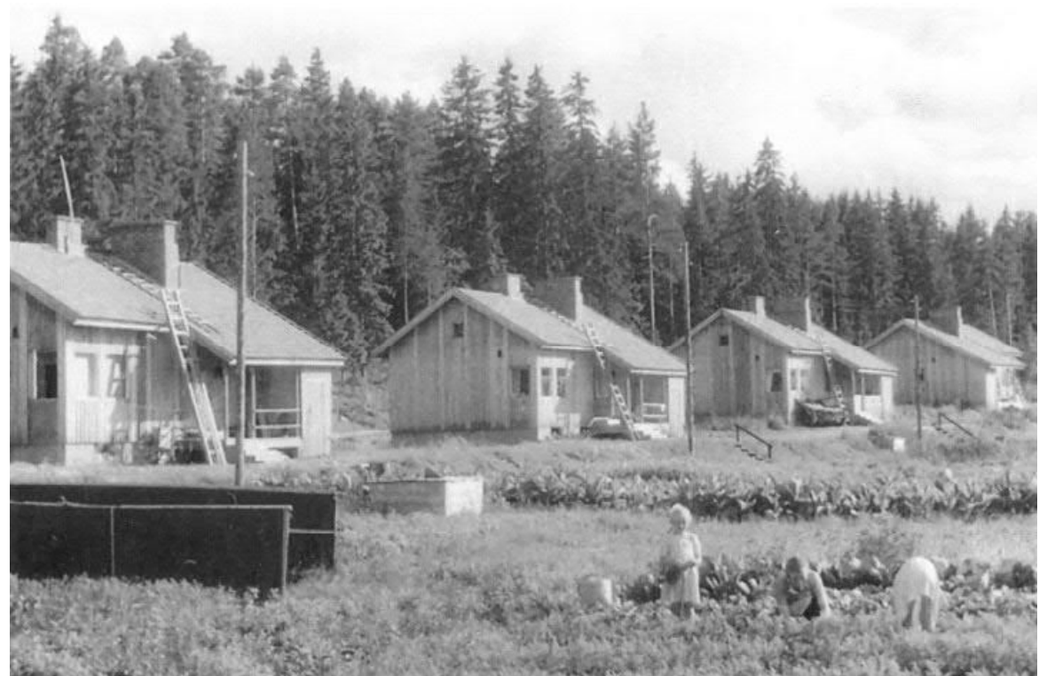
Puutalo Oy:n vielä typpitaloja rakenteilla Karkkilan Sudetin alueella 1940-luvun alussa. Samaa talotyyppiä pystytettiin Kannaksen alueelle ruotsalaistalojen viereen.
