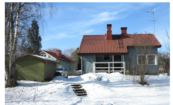
Puutalo Oy:n Högforssin talotyyppi. Korvenkatu 21
