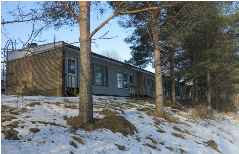
Suorakadun päähän jyrkästi nousevalle jokitörmälle rakennettiin vuonna 1966 kaksi 1-kerroksista pulpettikattoista rivitaloa.
