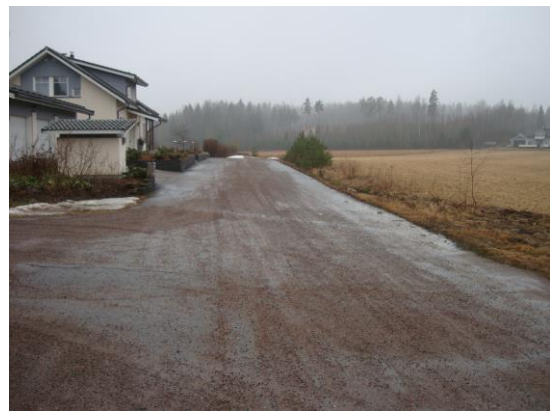
Kuva. Eteläinentie länsisuuntaan.
