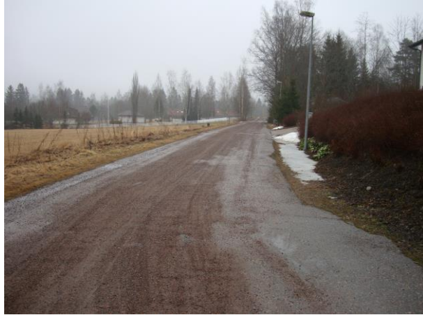
Kuva. Eteläinentie itäsuuntaan.
