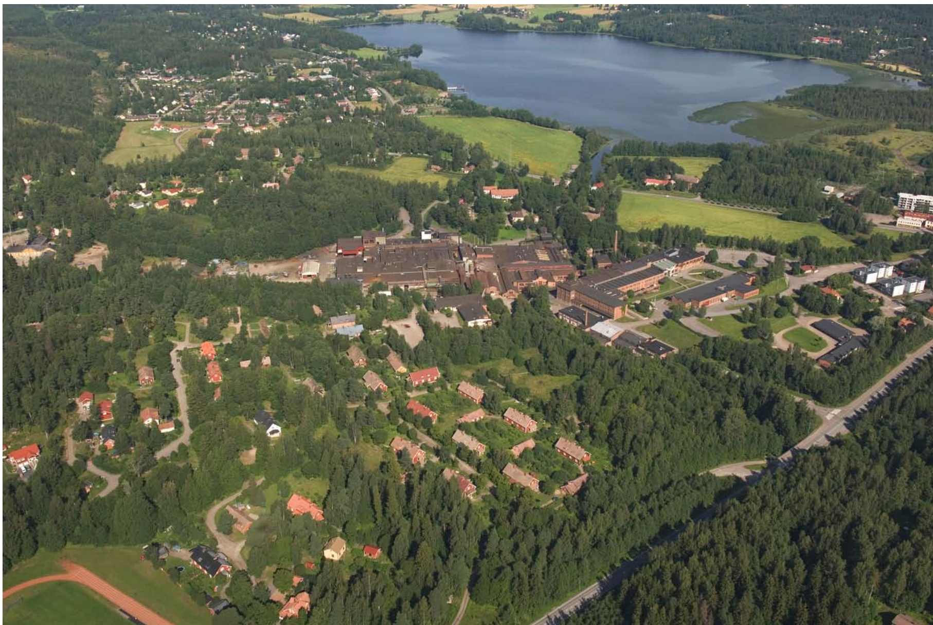
Etualalla Pusulantie ja Fagerkullan työväen asuntoalue, keskellä Höforsin tehdasalue, taustalla Vattolaa ja Pyhäjärvi. Pääosa kuvan alueesta on valtakunnallisesti arvokasta rakennettua kulttuuriympäristöä.
