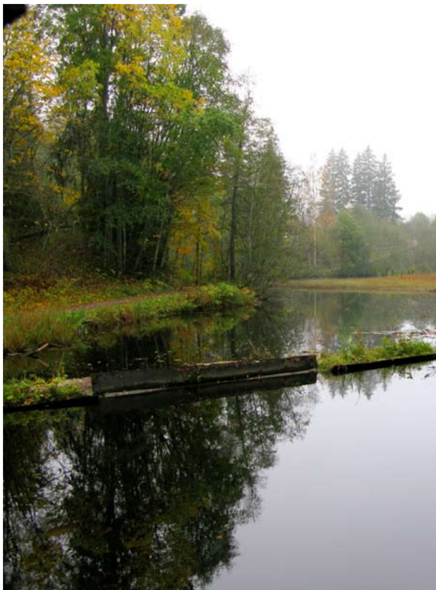
Karjaanjoen padottua uomaa.
