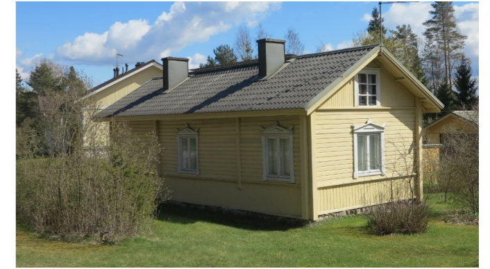
Nyhkäläntie 18 1800-luvun asuinrakennus
