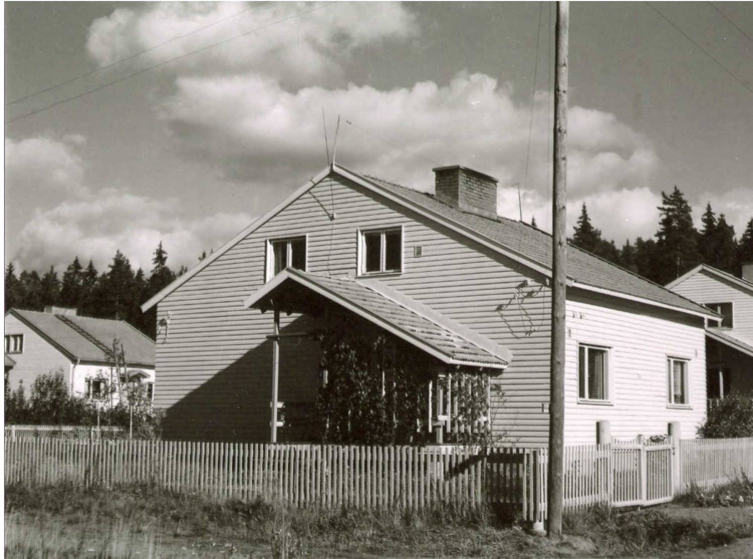
Polarin paritalojen julkisivuissa oli alunperin nurkista jirattu vaalea limilautavuoraus, pystyjakoiset vaaleasävyiset ikkunat sekä lyhyet räystäät. Katto oli verhoiltu tiellä kuten myös kuistin katos. Rakennuksen ilmeessä korostuu kuistin katon muoto ja säleiköt, sekä niihin liittyvät köynnöskasvit. Kuvassa näkyvän rakennuksen pihaa rajaa pystyrima-aita, vanhojen kuvien perusteella olivat pensasaidat kuitenkin yleisempiä. Kuva Karkkilan museo.
