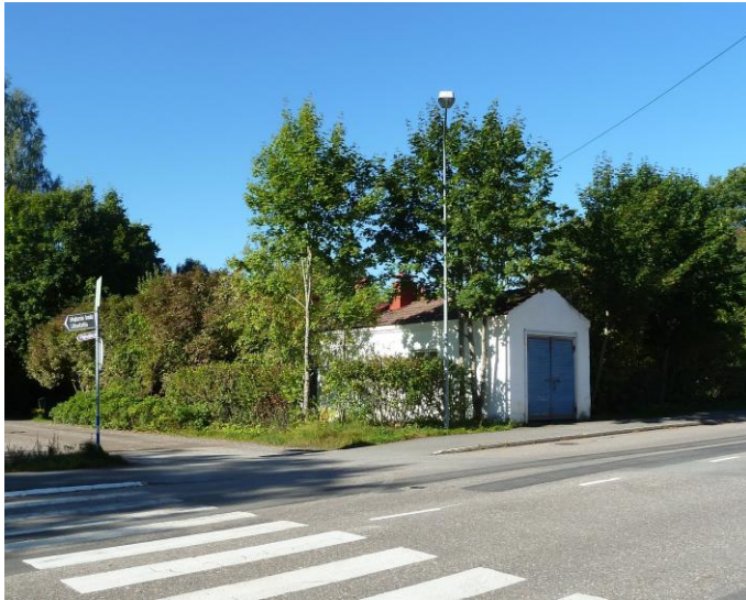
Kuva 12. Autotalli sijoittuu aivan Valtatien puoleiselle tontin rajalle. Rakennus toimii paremmin varastorakennuksena kuin autotallina.
