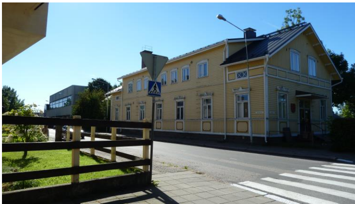
Kuva 5. Kuvassa on entinen kaupungintalo Anttilankadun puolelta nähtynä elokuussa 2016.
