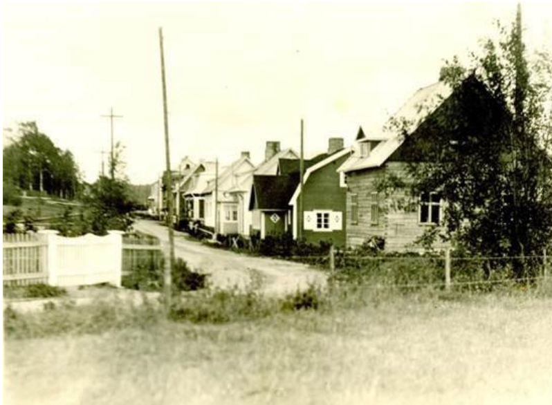
Kuva 50. Kuvassa näkyy aikanaan Valtatie 18:sta sijainnut puolitoistakerroksinen jyrkkäkattoinen omakotitalo. Sen vieressä on ns. Apilatalo, joka jää selvästi korttelissa olevien muiden talojen alapuolelle. Kattolappeella on kattolyhty tuomassa valoa rakennuksen toisen kerroksen keskiosaan. Katunäkymässä kattopinnan suhde julkisivuun on tässäkin talossa ollut merkittävän suuri (lähde: Karkkilan museotoimi).
