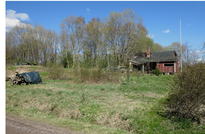
Näkymä Korpiniitynkadulta pohjoiseen Mäkilänpuistoon. Edustalla palossa tuhoutunut autiona oleva asuinrakennus.
