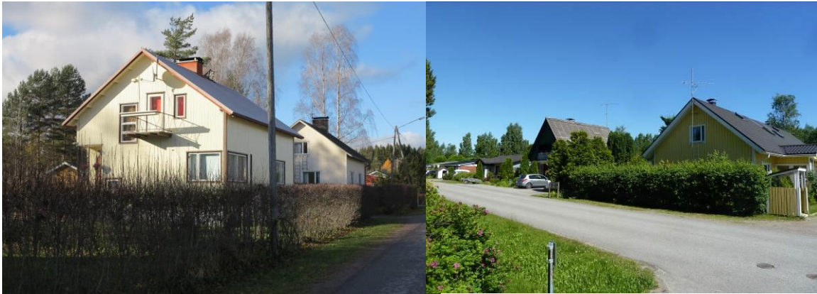
Kantoniitynkadun varrella on pieni 1950-luvun 1½-kerroksisten tyyppitalojen kokonaisuus.
