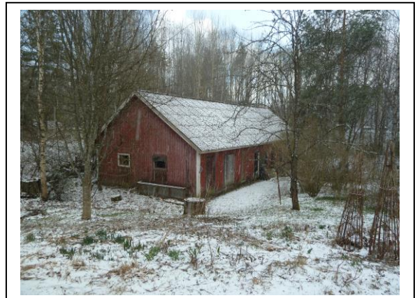
Kuvassa 3 on huonokuntoinen isokokoinen talouksrakennus, joka kuuluu edellisen kuvan asuinrakennuksen pihapiiriin. Kaavassa on osoitettu pihan toiselle puolelle paikka 100 k-m 2 suuruiselle talouksrakennukselle.
