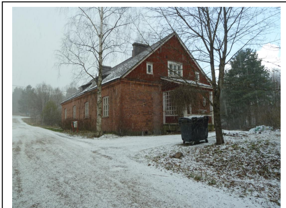
Kuvassa 2 on kaavanmukaisella yleisellä alueella sijaitseva osittain tiilestä rakennettu asuintalo, joka on suojeltu. Kaavaluonnoksessa on osoitettu tontti ko. asuinrakennukselle ja piharakennukselle.
